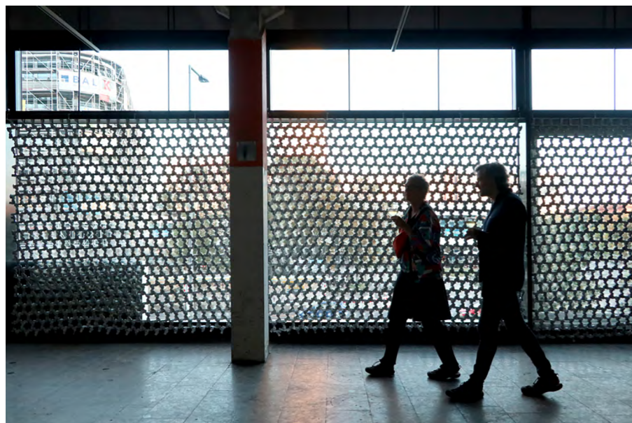
Fensterfront am Standort Karl-Liebknecht-Straße mit Fassadenarbeit von Folke Köbberling in Zusammenarbeit mit Alexa Kreissl.
